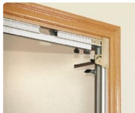
Colocación de los tapajuntas utilizando como guía los topes dispuestos al efecto.
