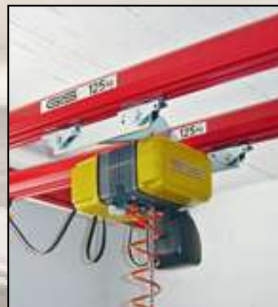
* Grúa suspendida birraíl.
